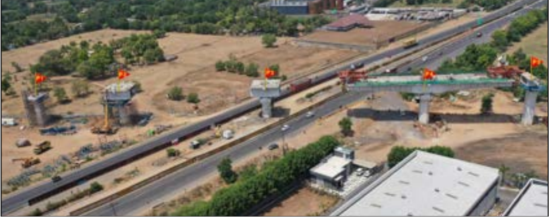
गुजरातमधील खेडा जिल्ह्यात पीएससी पुलाचे बांधकाम प्रगतीपथावर
