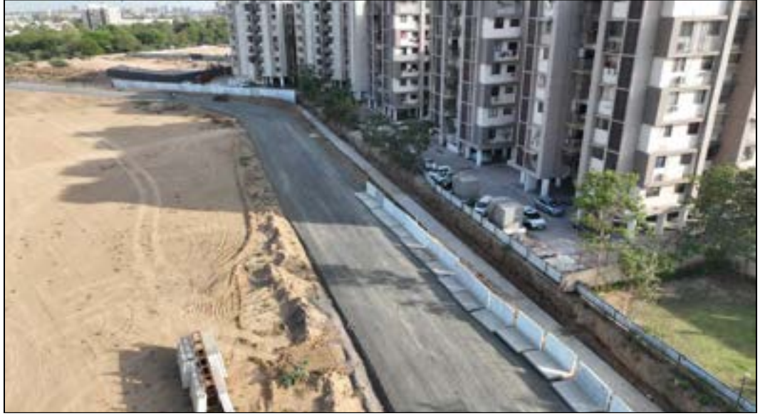
रस्त्याचे काम आणि प्रीकास्ट रिटेंनिंग वॉल उभारणीचे काम, साबरमती डेपो, गुजरात
