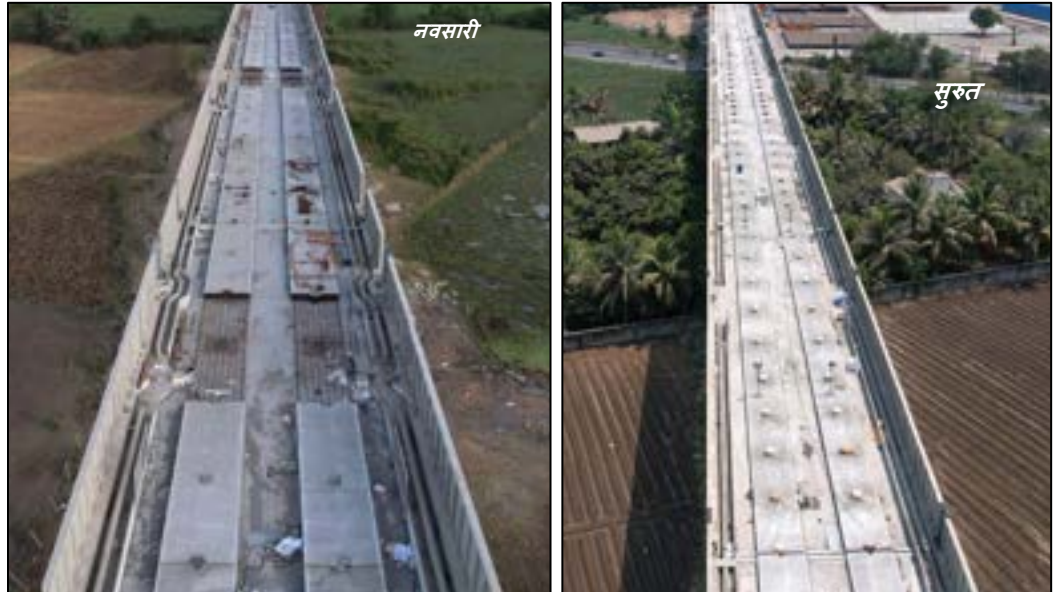
गुजरातमध्ये ट्रॅकचे काम प्रगतीपथावर
